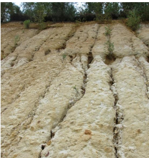
Nombreuses traces d'érosion
